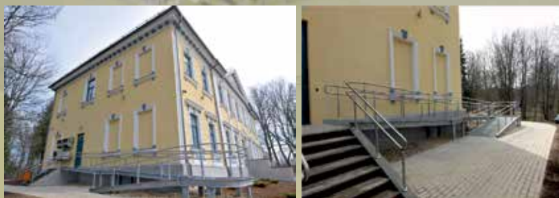
Izbūvēta uzbrauktuve cilvēkiem ratiņkrēslos
