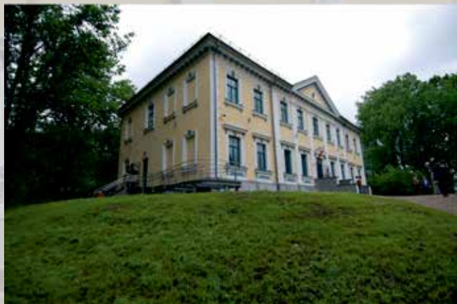
Ēkas fasādes krāsošanai izmantota speciāla kaļķu krāsa gaiši dzeltenā un pelēcīgi zaļganā tonī
